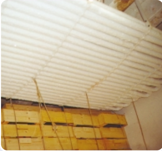
Une installation efficace. Les tuyaux frigorifiques avec les boîtes de poisson calé sous les tuyaux.
